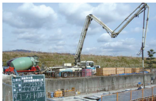
加納浄水場の耐震化
