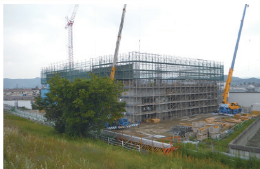
脱水機棟築造
