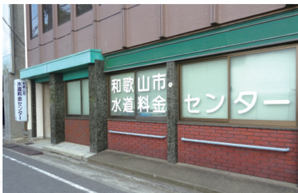
和歌山市水道料金センター
