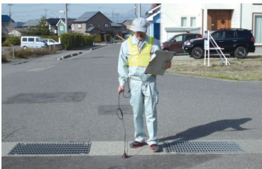
漏水調査状況
