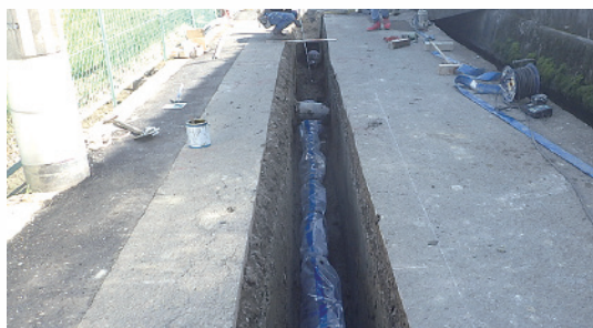
管路の更新状況②
