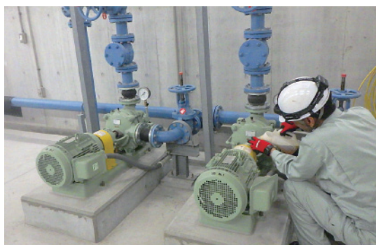
設備点検状況②
