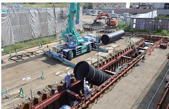
場内配管の布設
