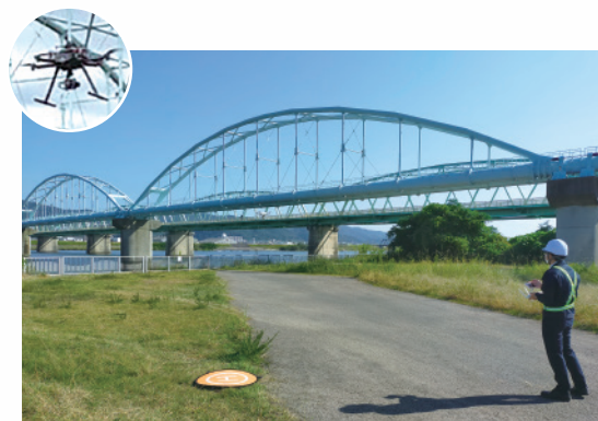
水管橋ドローン点検状況
