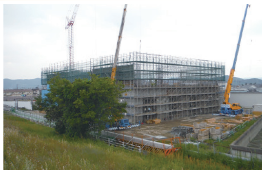
脱水機棟築造
