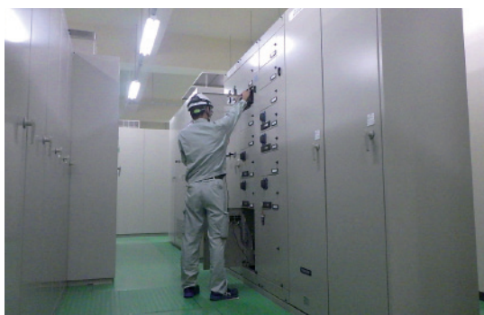
設備点検状況①
