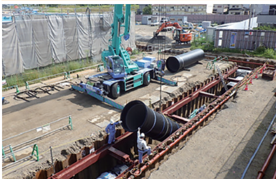
場内配管の布設
