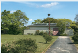
4 秋葉山配水池
