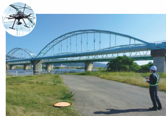
水管橋ドローン点検状況
