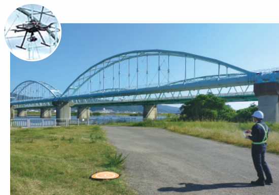
水管橋ドローン点検状況
