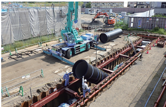
場内配管の布設
