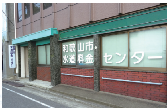
和歌山市水道料金センター
