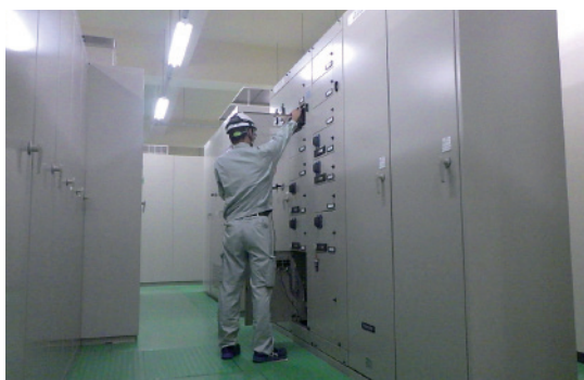
設備点検状況①
