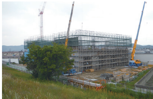
脱水機棟築造
