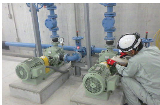
設備点検状況②
