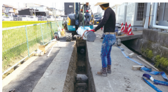
管路の更新状況①
