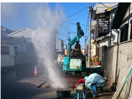
施策2 管路の維持管理
