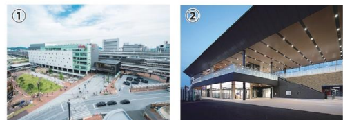
シームレスな歩行者動線(姫路市) 分断を解消する橋上駅舎(岩国市)
