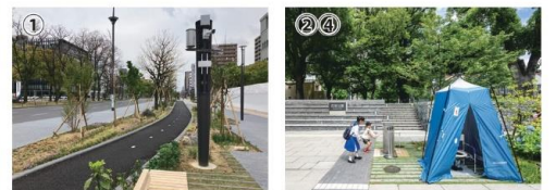
スマートポールの設置(四日市市) 雨庭による雨水活用と防災(熊本市)
