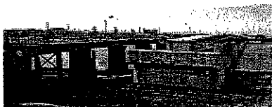
河西橋の架替
