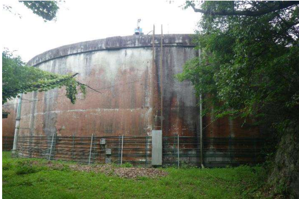
（花山配水池 昭和42年稼働 57年経過）
