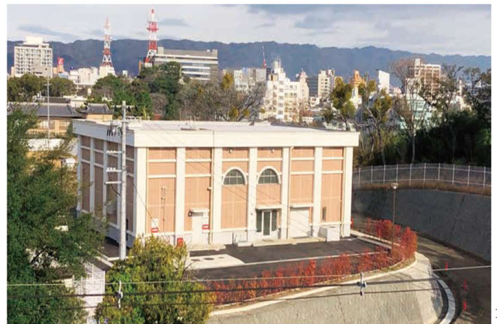
（真砂配水場 平成31年稼働）
