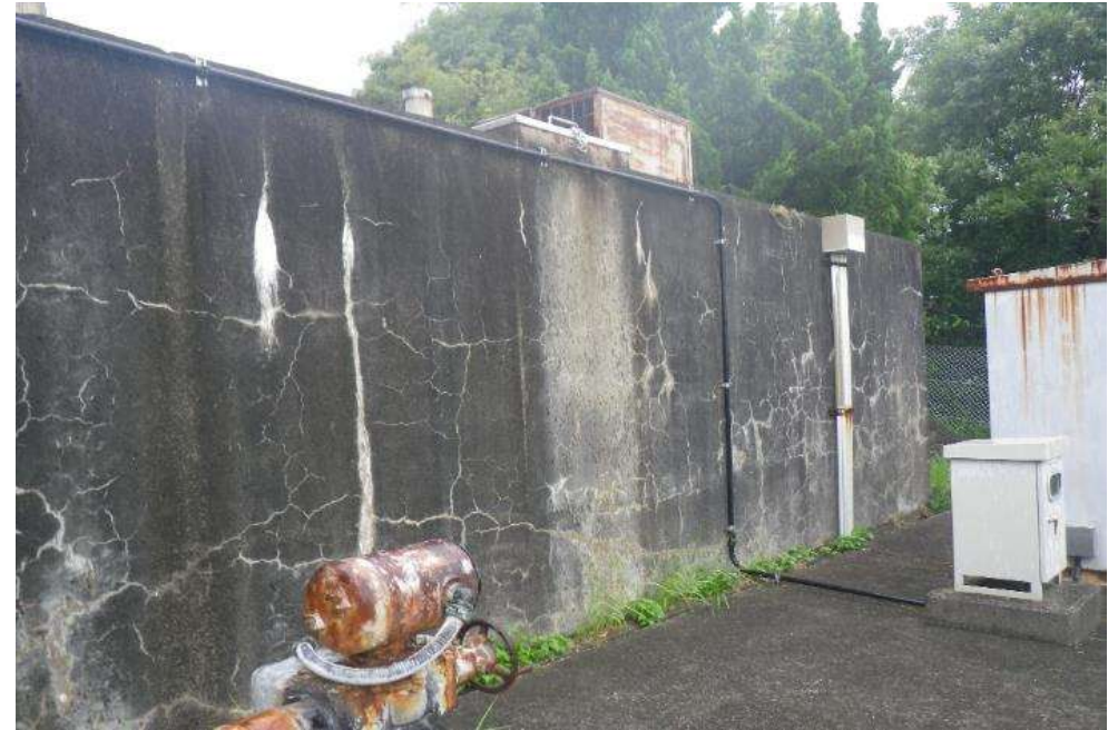
（鳴滝配水池 昭和41年稼働 58年経過）
