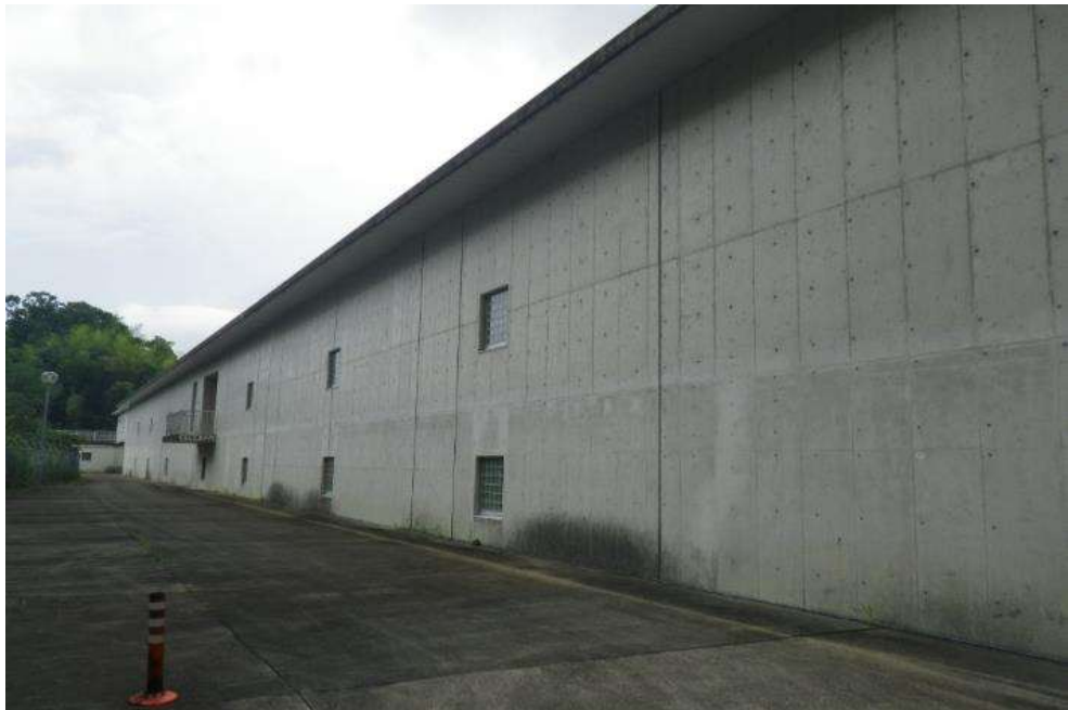
（和佐配水池 平成22年稼働）
