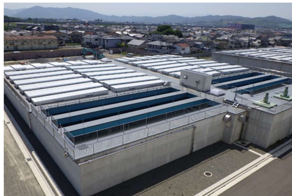
(横流式沈澱池 平成31年稼働)
