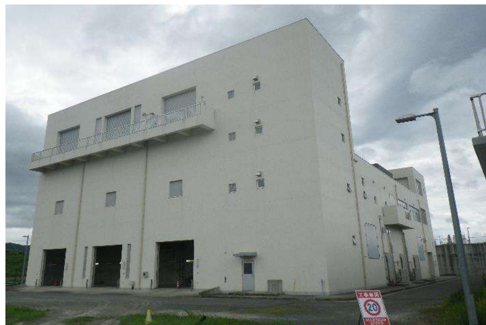
(脱水機棟 平成28年稼働)
