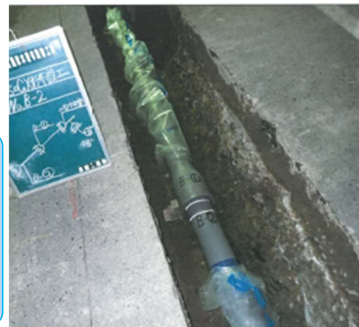
管路の更新状況
