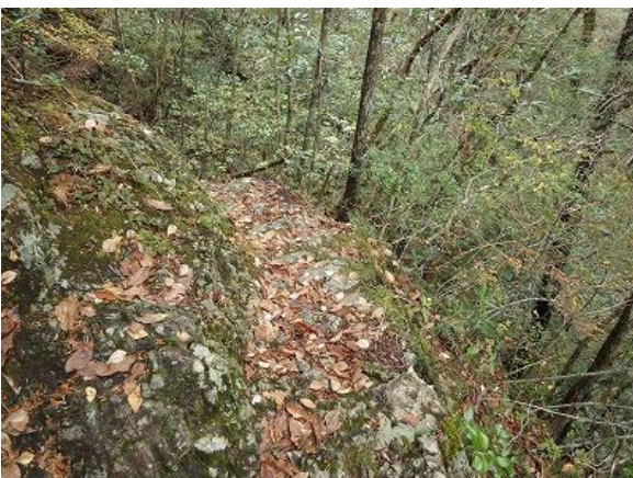
すべりやすく、手すりもない岩場があります。
