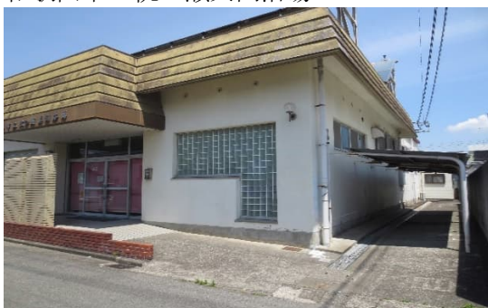
和歌山市立杭の瀬共同浴場
