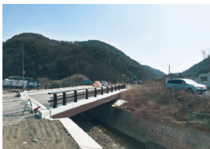
坂田磯の浦線の進捗状況
