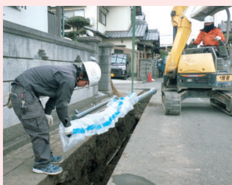
老朽管更新の様子
