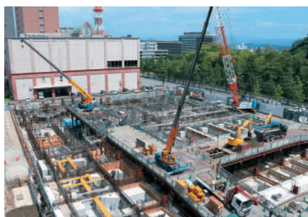
建設中の和歌山城ホール
