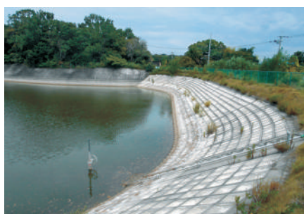
整備後のため池
